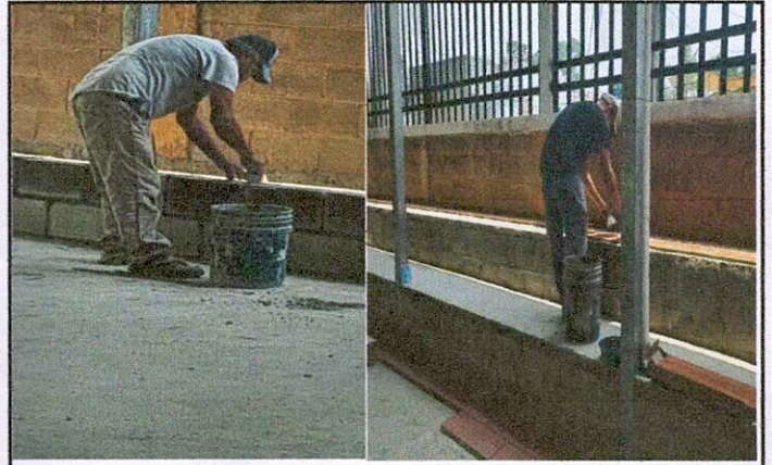
Foto 2: fundicion de Gradas en area de usos multiples
