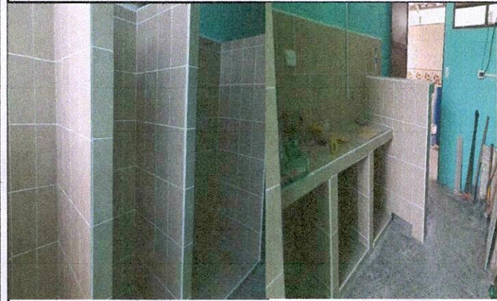
Foto 3: colocacion de azulejo en gabinetes de cocina jornada Matutina
