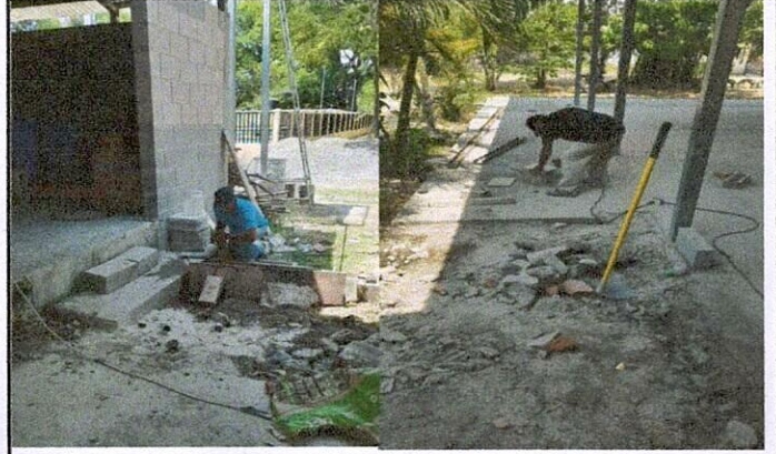
Foto 2: fundicion de rampa para bajar a area de usos multiples
