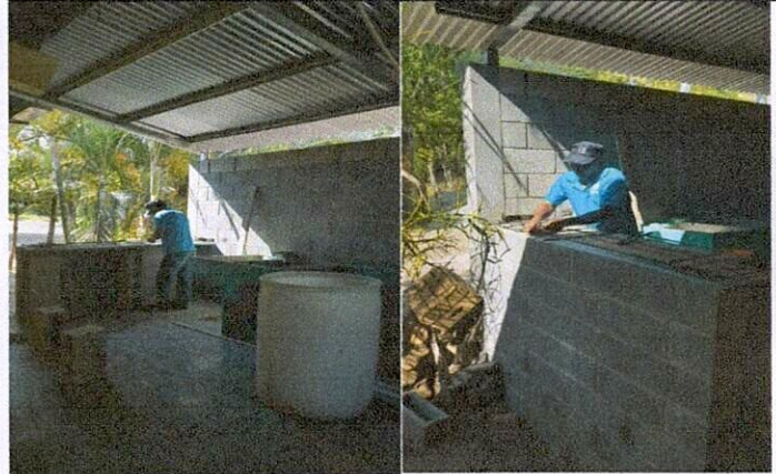
Foto 4: fundicion de desayunador en cocina de leña
