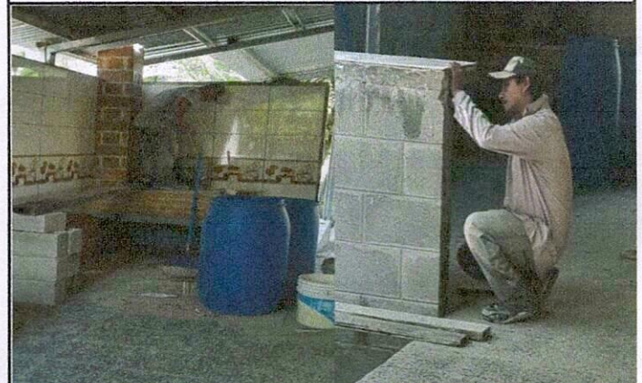
Foto 4: colocacion de azulejo en cocina de Leña
