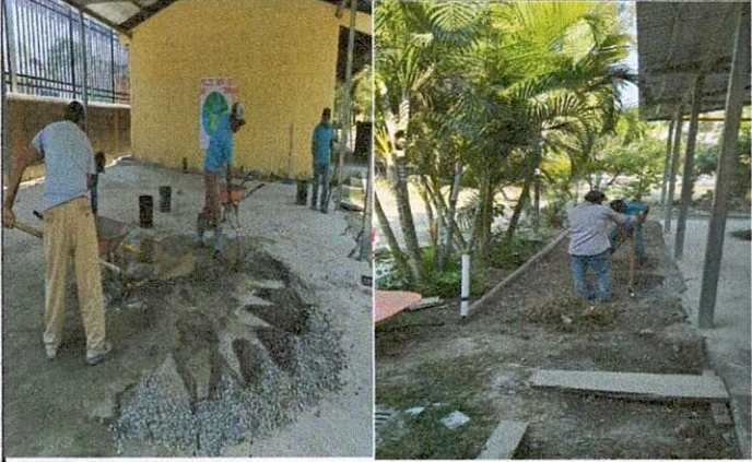
Foto 1: fundicion de extension, ampliacion de torta de cemento en area de usos Múltiples
